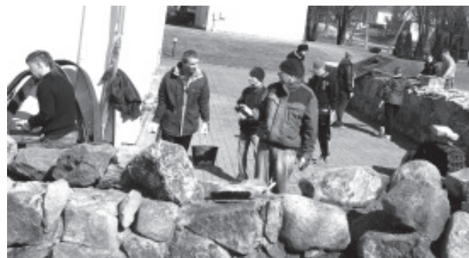
На толоке по строительству ограды. Фото: 2x АЛАР ТАСА
